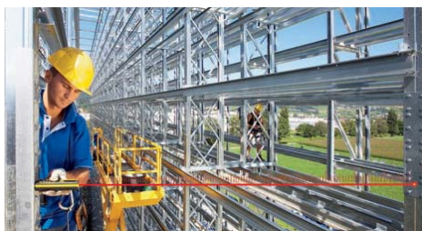
Costruzione di capannoni – Misura di distanze elevate con il mirino digitale
