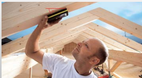
Falegnameria – Misura dell'inclinazione sul soffitto grazie al sensore di inclinazione a 360°
